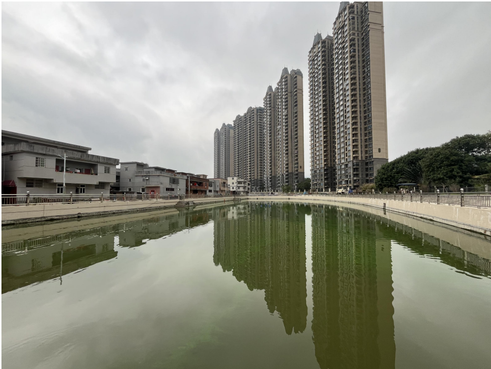
照片 8 村前水塘 2 (镜头向北西)
