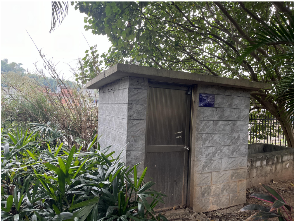
照片4 2井现状（镜头向西）
