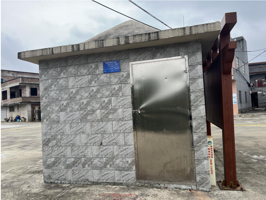
照片3 1井现状（镜头向西）
