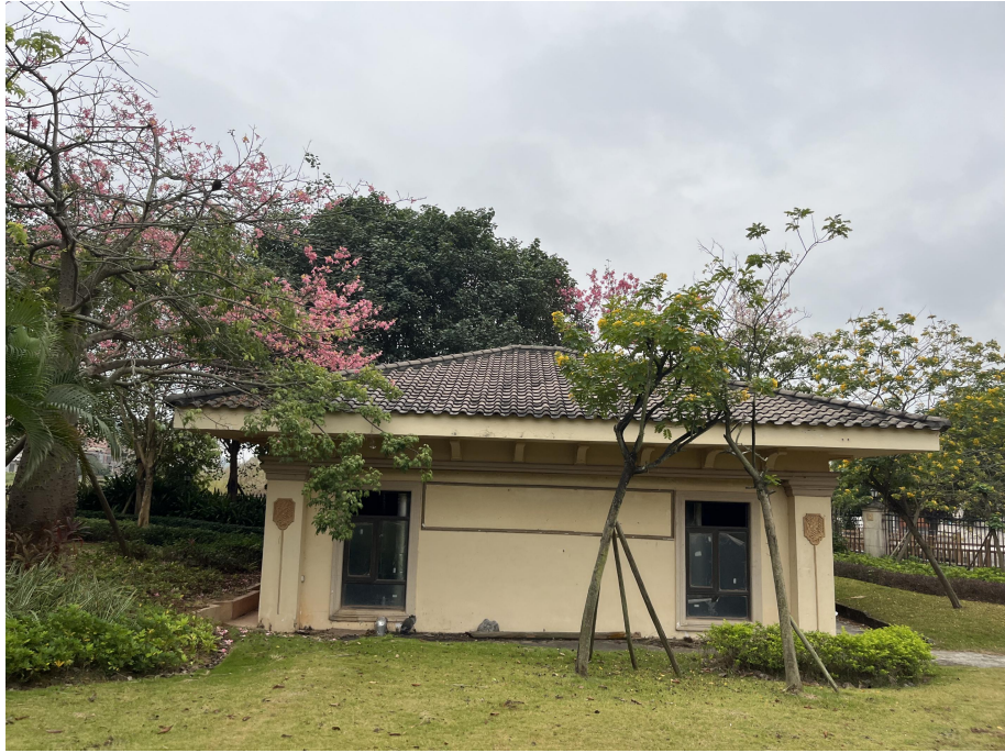
照片5 变频泵房（镜头向北西）
